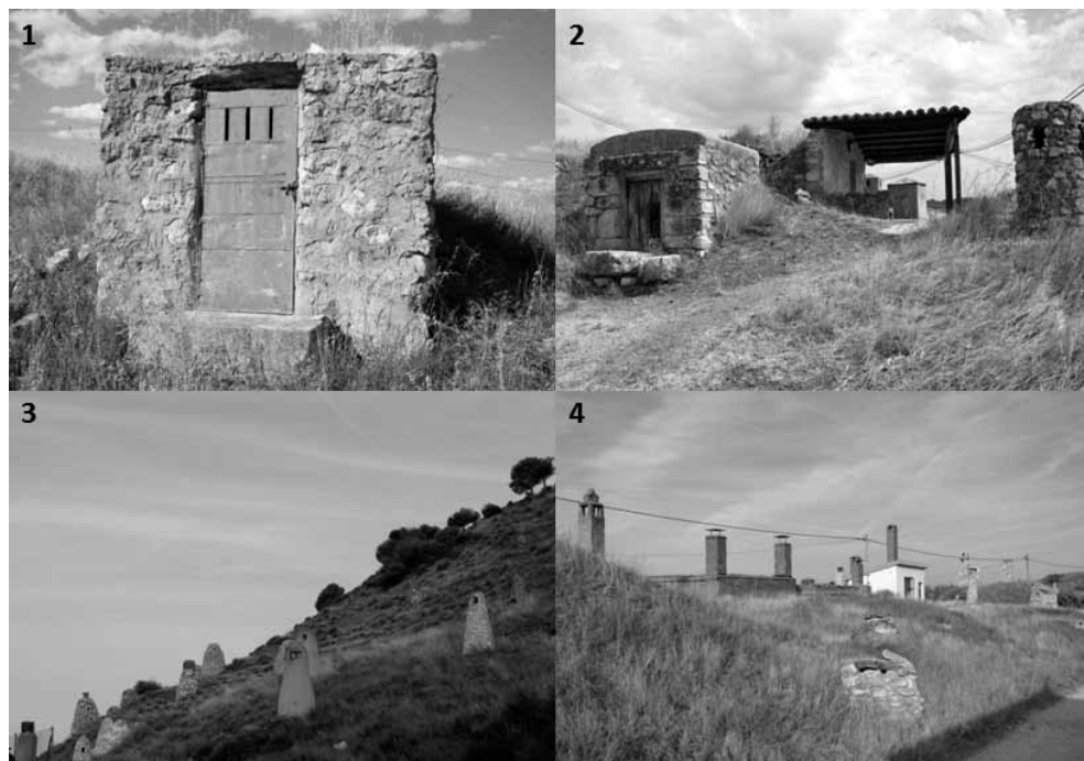
Figura 3.- Elementos arquitectónicos de las bodegas. 1) Zarcera en Torquemada (Palencia). 2) Zarcera y respiradero en Cubillas de Santa Marta (Valladolid). 3) Chimeneas y respiraderos en Peñafiel (Valladolid). 4) Chimeneas en Villahoz (Burgos).
