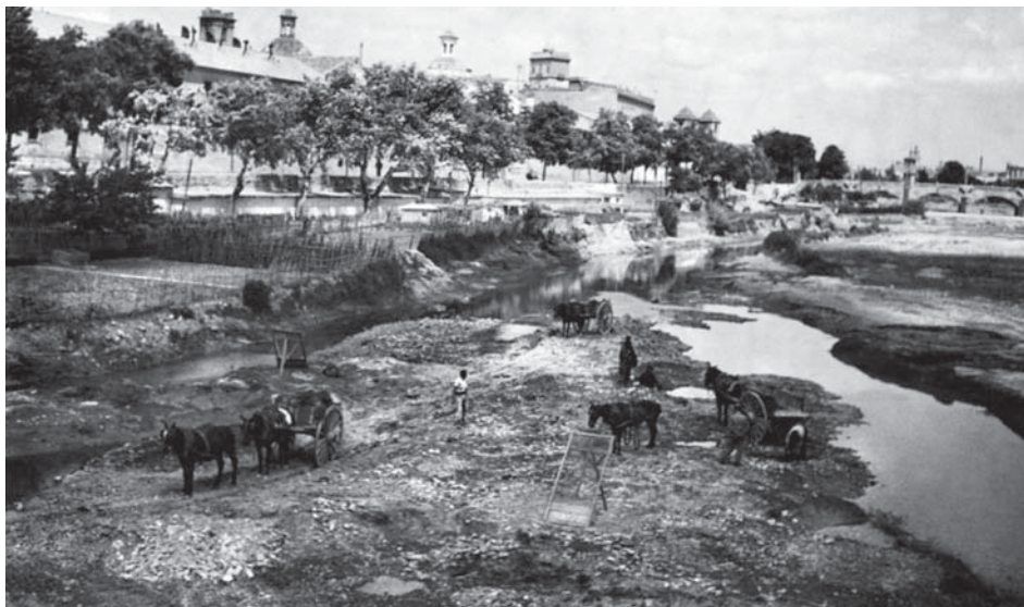
Figura 4: Las extracciones en el cauce provocan hoyos y otras irregularidades entre el Puente del Real y la Pasarela de la Exposición. Al fondo, parcelas cultivadas (hacia 1910). Fuente: Fondo Tívoli.
