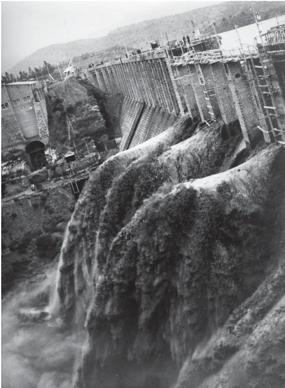
Figura 3. Presa de Sitjar en construcción. Crecida del Mijares (1957).
