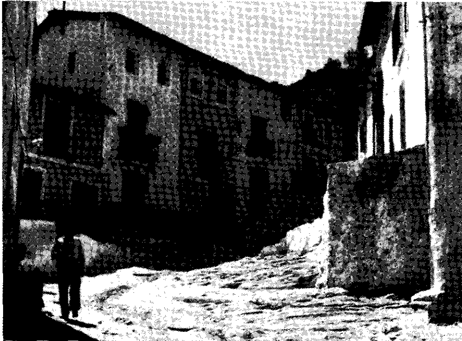
Fig. 2.—Calle de la Triaca, al pie del castillo. Caserío rural escalonado.
