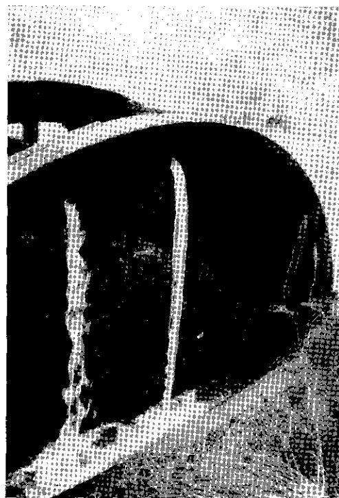
Fig. 2.—Noria de Benijófar sobre el Segura: detalle de la rueda de madera y la pileta de donde arranca la acequia.
