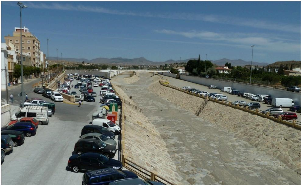
Figura 5. Encauzamiento en dos niveles de la rambla de Albox a su paso por el casco urbano. Fuente: elaboración propia de los autores.
