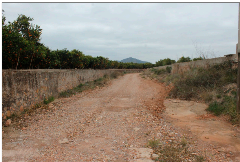
Figura 12. Barranc del camí d'Onda en l'encreuament amb el camí de la Travessa (Nules)
