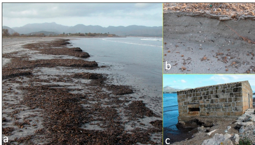
a) Bermes vegetals formades per l'acumulació de fulles mortes de Posidonia oceanica a la zona de sa Marina; b) registre sedimentari a la platja; c) búnquer col·lapsat degut al retrocés que està sofrint la línia de costa actualment.
