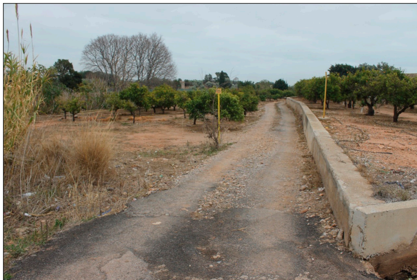
Figura 6. Fotografia del barranc de l'Hospital en el camí Quart Sedeny (Vila-real)
