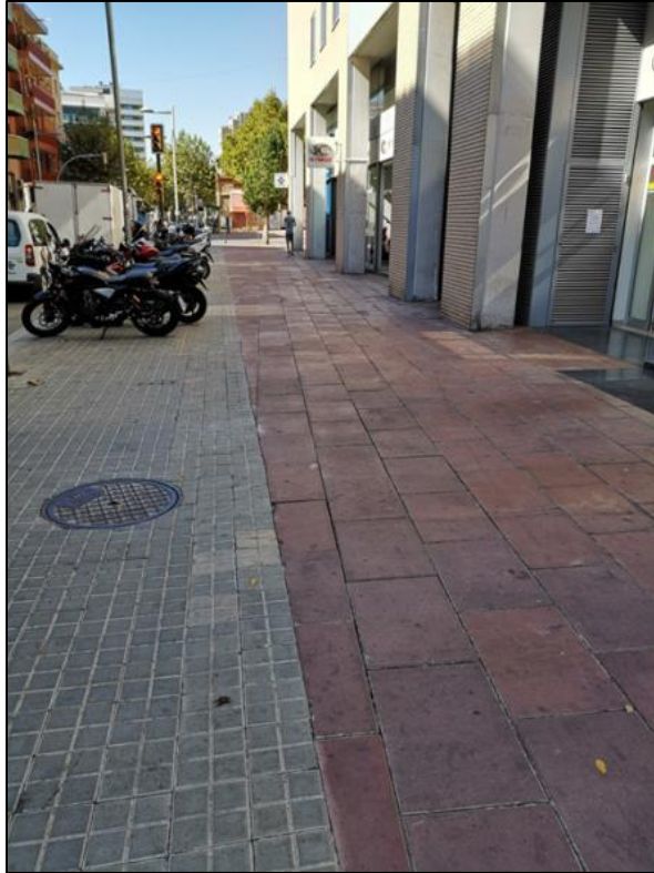
Ensanche de la acera de Santa Eulàlia Avenue/ Alejandro Caamaño
