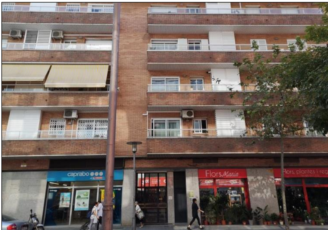
Bloques de la Calle Santa Eulàlia/ Alejandro Caamaño
