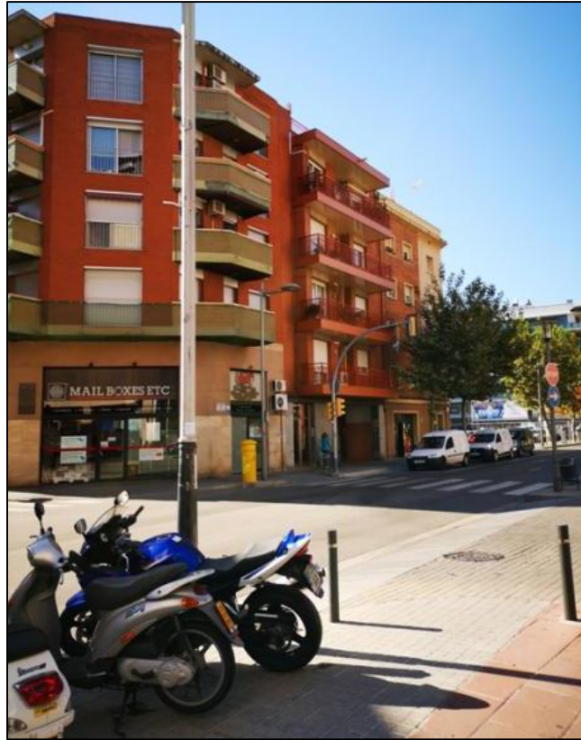
Bloques de la Calle Santa Eulàlia/ Alejandro Caamaño
