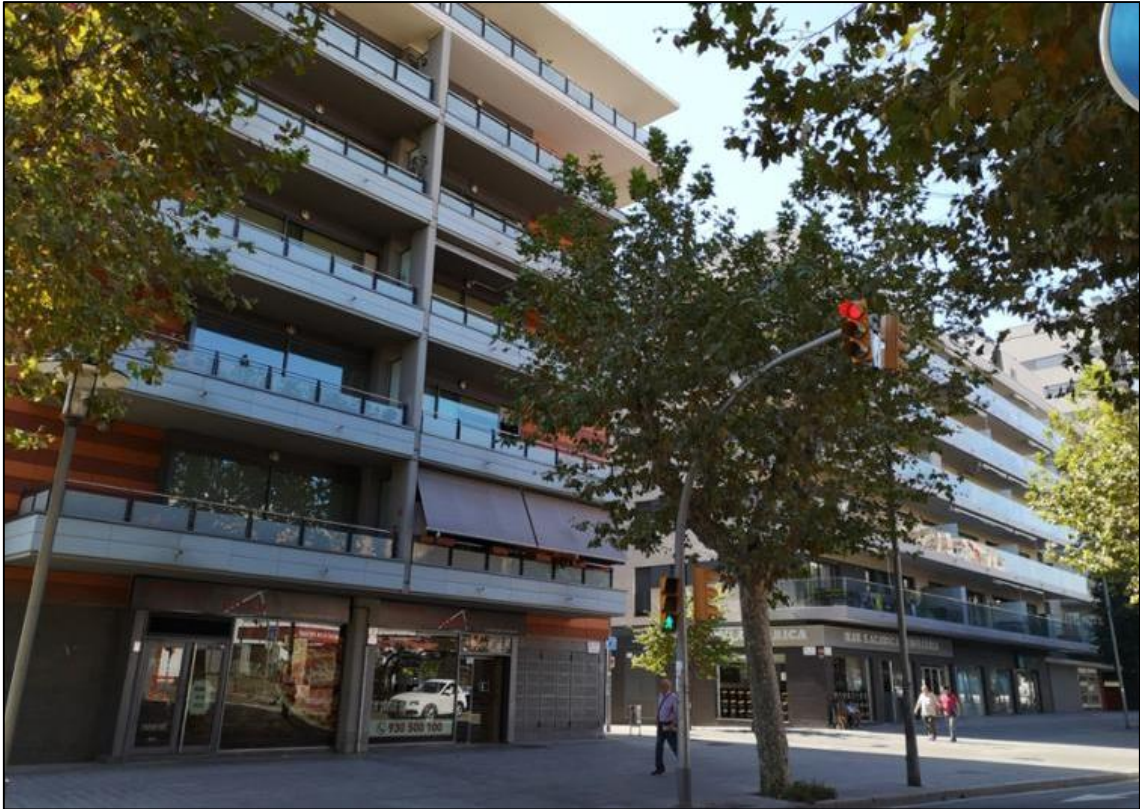
Bloques de Santa Eulàlia Avenue
