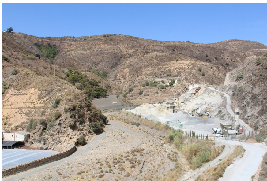
Figura 3. Encauzamiento histórico, invernadero en construcción y zona de extracción de áridos
