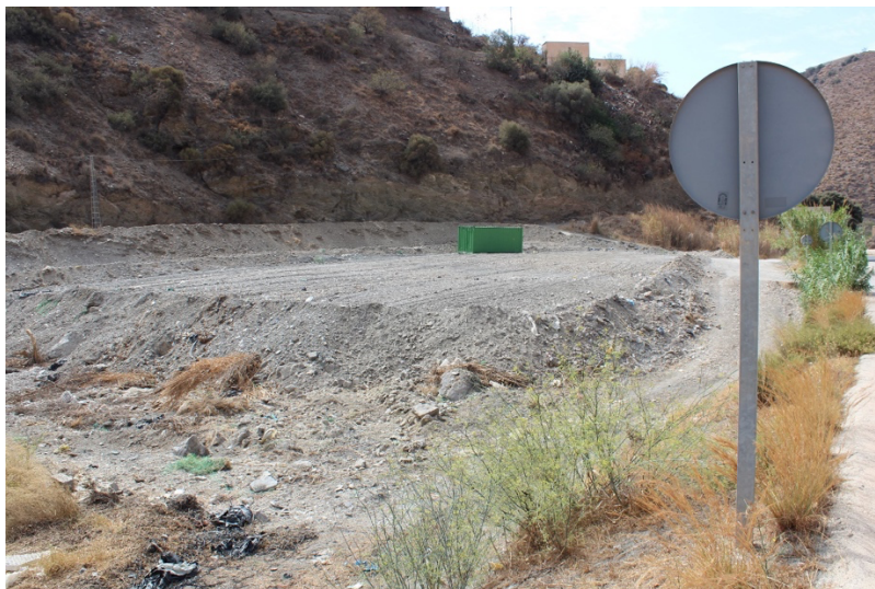
Figura 5. Enterramiento de suelos de vega por áridos para elevar el terreno
