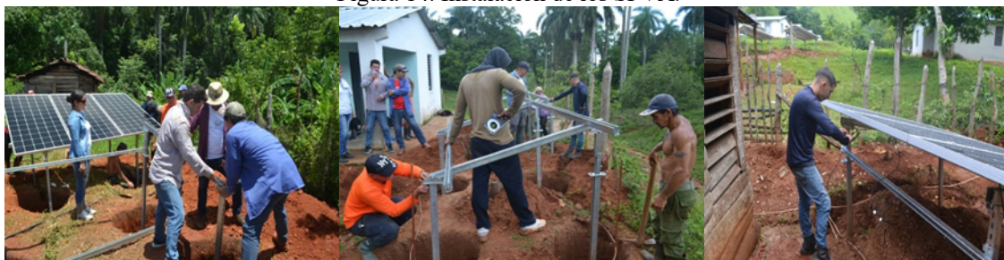
Figura 14. Instalación de los SFVA.
