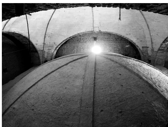
Fig. 4. Espacio bajo la cubierta de la iglesia parroquial de San Jaime de Vila-Real (Castellón), que revela la maestría de Juan José Nadal en el manejo de la bóveda tabicada. Foto: Vegas & Mileto.
