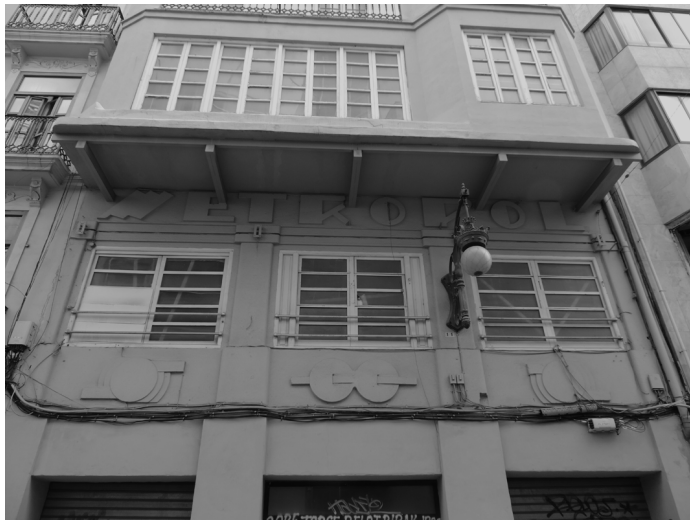
Fig. 6. Rotulación en fachada del cine Metropol . Fotografía del autor, septiembre de 2017.
