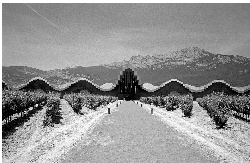
Fig. 3. Santiago Calatrava. Bodegas Ysios . 1998-2000. Laguardia, Álava (España). (Fotografía: R. Lumbreras)
