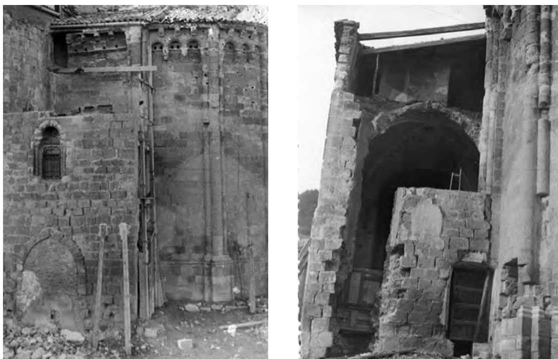
Fig. 8. Proceso de desmonte de la capilla adherida a la nave de la Epístola, aprox. 1961. Fuente: Archivo Tricás.
