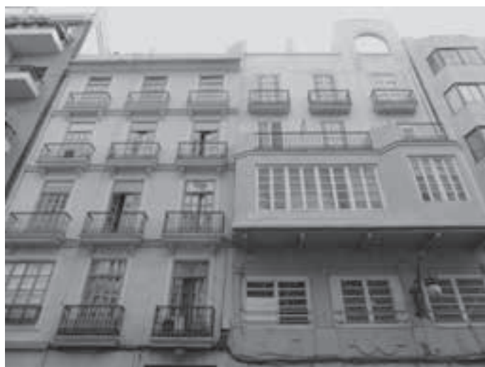
Fig. 4. Vista parcial de los edificios de la calle de Hernán Cortés, 7 y 9. Fotografía del autor, septiembre de 2017.
