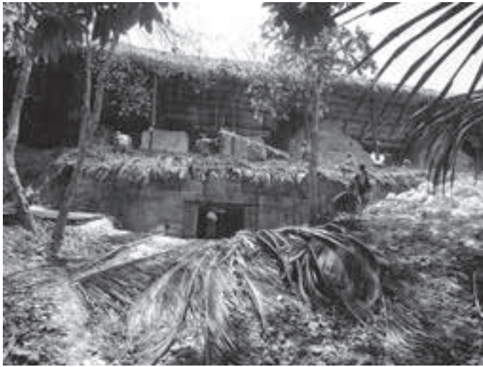
Trabajos de construcción de la cubierta de la Subestructura 2 de la Acrópolis de La Blanca.
