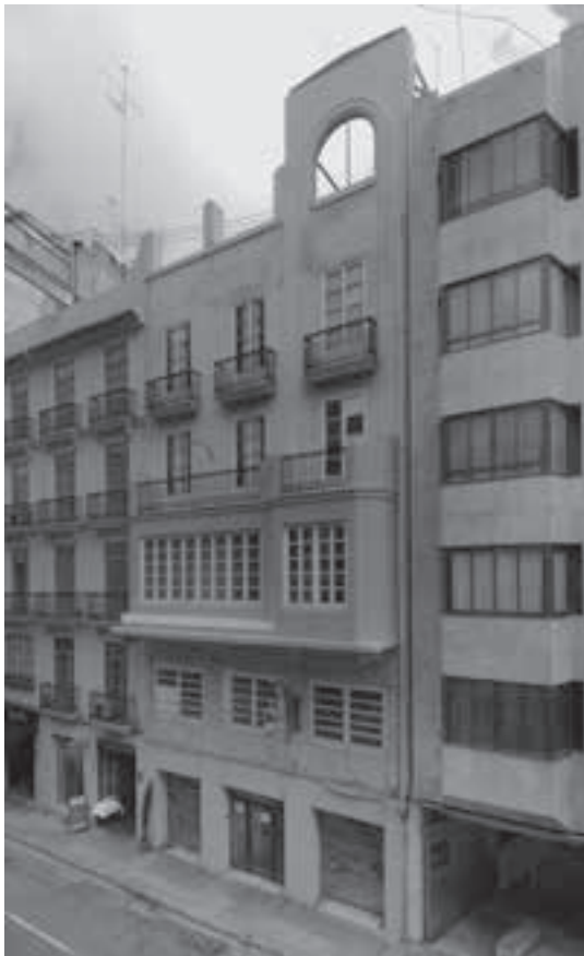
Fig. 5. Edificio del cine Metropól en la calle de Hernán Cortés, 9. Fotografía de Mateo Gamón.
