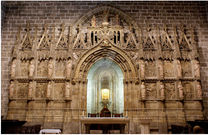
Fig. 6. Antiguo trascoro de la catedral de Valencia en su actual ubicación, en la capilla del Santo Cáliz, 1392-1444.
