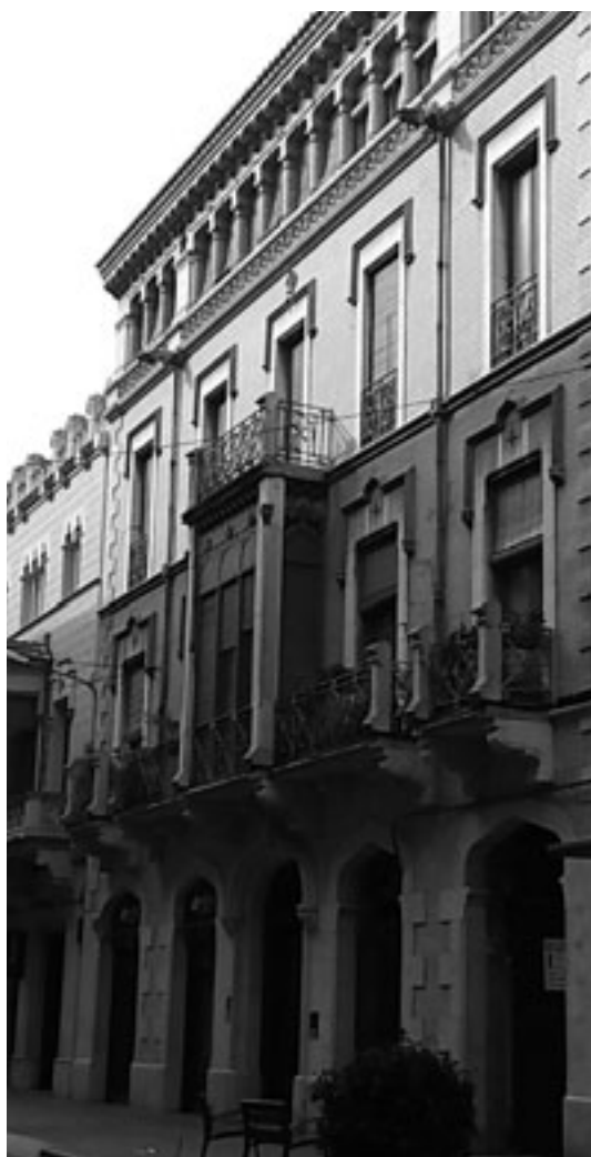
Fig. 1. Casa Roger. Calle Monturiol, nº 9. Josep Azemar Pont. 1888. Figueres.
