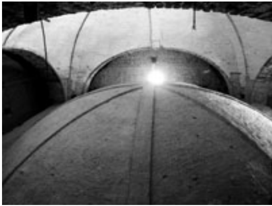
Fig. 4. Espacio bajo la cubierta de la iglesia parroquial de San Jaime de Vila-Real (Castellón), que revela la maestría de Juan José Nadal en el manejo de la bóveda tabicada. Foto: Vegas & Mileto.
