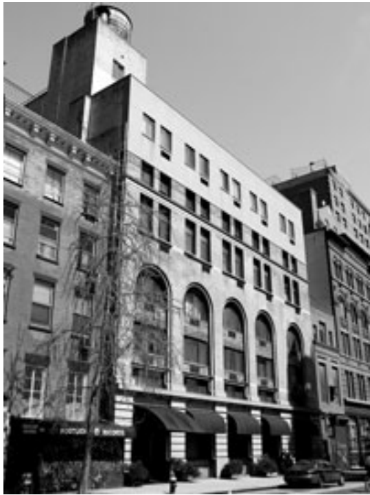
Fig. 6. Edificio de la Edison Electric Co. en 115 East 12 Street (1906), donde T.A. Edison recurrió a las bóvedas de Rafael Guastavino como sistema de construcción ignífugo. Foto: Vegas & Mileto.
