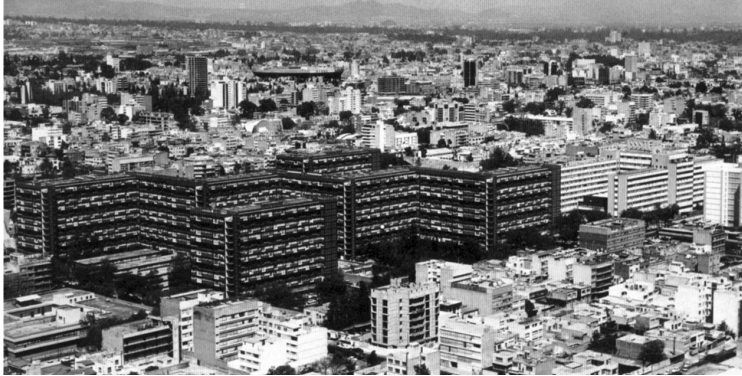
Vista aérea del Multifamiliar Alemán recién terminado.
