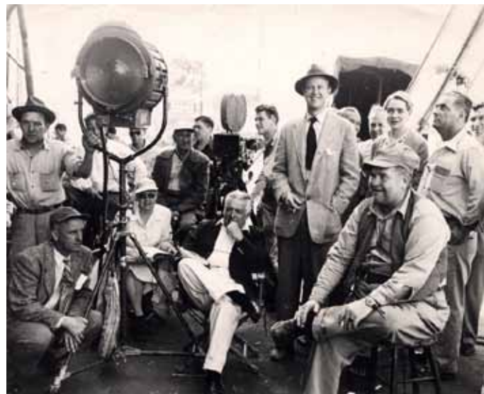
Figura 5. Brown con el equipo de rodaje de Intruder in the Dust (1949) en exteriores reales de Oxford, Mississippi
