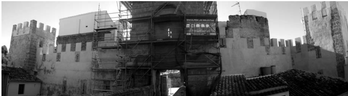
Fig. 5. Castillo de Buñol. Fachada norte restaurada (2008-2009). (Fotografía E. Díes).
