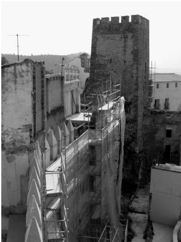
Fig. 4. Castillo de Buñol. Fachada oeste restaurada (2008-2009). (Fotografía J.L. Jiménez).
