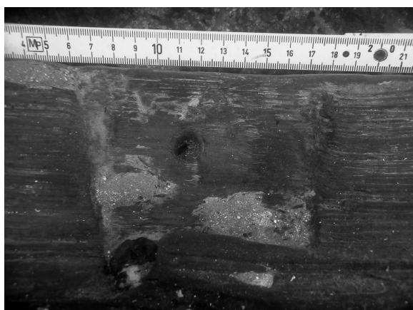
Fig. 10. Vista superior de la T-6, exfoliada, en la que se aprecia parte de una mortaja y clavija.
