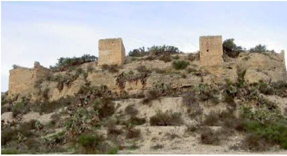
Fig. 4: Panorámica de los restos de la fortificación almohade de Castillo del Río (fotografía Juan Antonio Pérez Meca).
