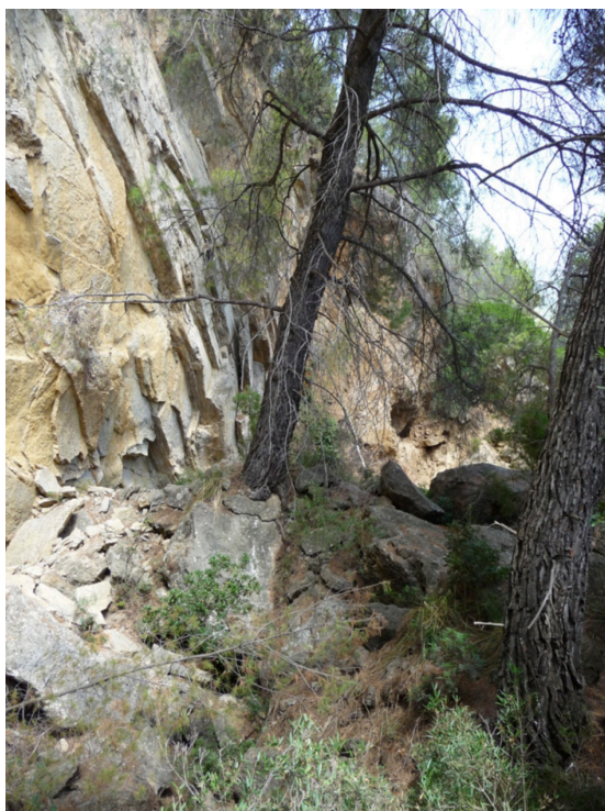
Fig. 4. Aspecto del gran socavón con derrumbes recientes (vista hacia el NE) (Foto: M. H. Hermanns, 2012).
