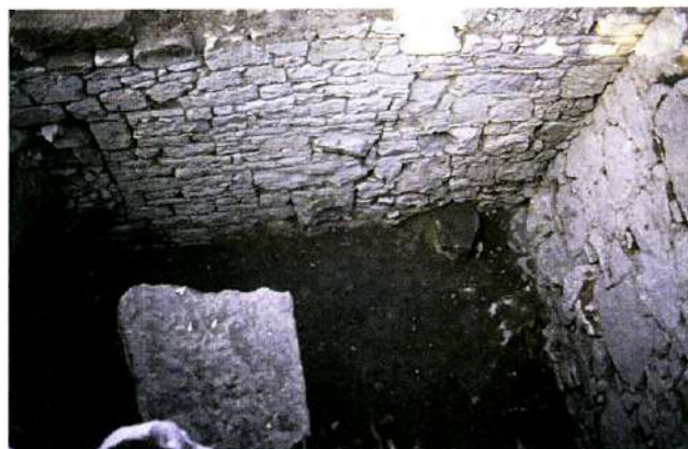
Fig. 4. El pilar exento (UE 1027).
