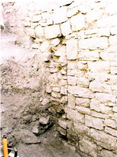
Fig. 6. Bloqueo de un vano del muro 1018.
