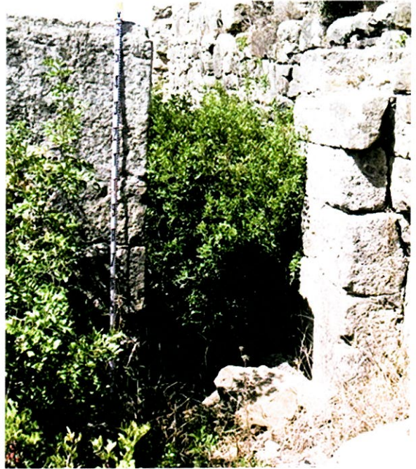
1.3. Fig. 7. Puerta de jambas rectas sin batientes de las Cámaras Montalbán IV.
