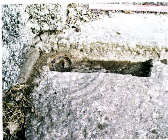
1.3. Fig. 11. Detalle del umbral de la puerta con galce de piedra.
