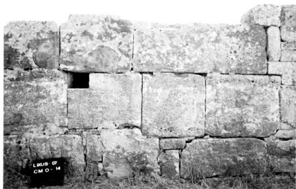
1.3. Fig. 4. Muros CM.IV y CM.V, los únicos trabados y enjalbegados con mortero (ver fig. 6).
