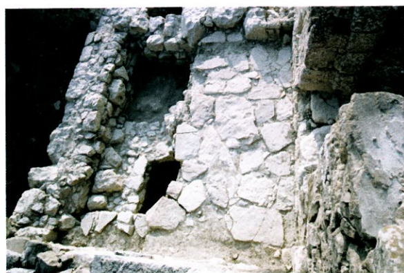
1.4. Fig. 10. Pavimento cortado para construir una trinchera de cimentación
