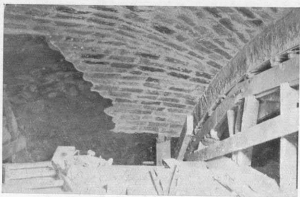
Lado de la Epístola en el que aparece el arco nuevo y su unión con el nicho.
