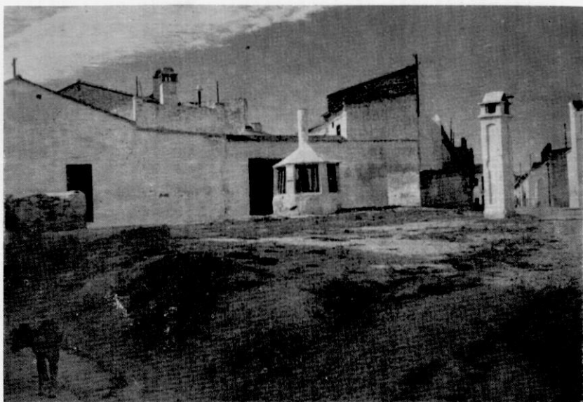
Fig. 1.—BARRIO DE LAS CUEVAS. Chimeneas y respiraderos de las viviendas troglodíticas, cuyo techo viene a coincidir con el nivel de las calles del pueblo; están en vías de abandono.
