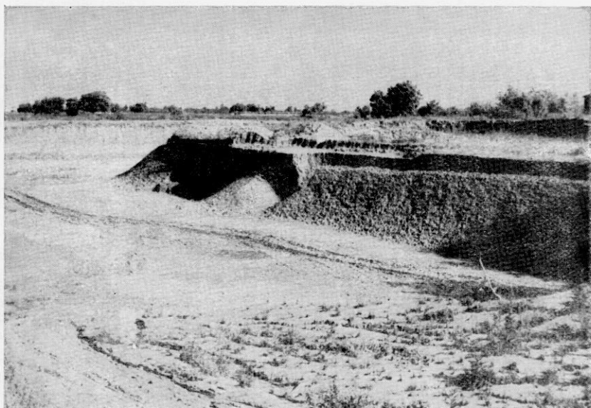
Fig. 2.—YACIMIENTO DE ARCILLA EN EXPLOTACIÓN. En el Pla de Quart, junto a la carretera de Madrid, la excavación avanza en horizontal a expensas de los cultivos. Se descava la tierra rojiza, que es acarreada a medida de las necesidades como primera materia de los productos bastos.
