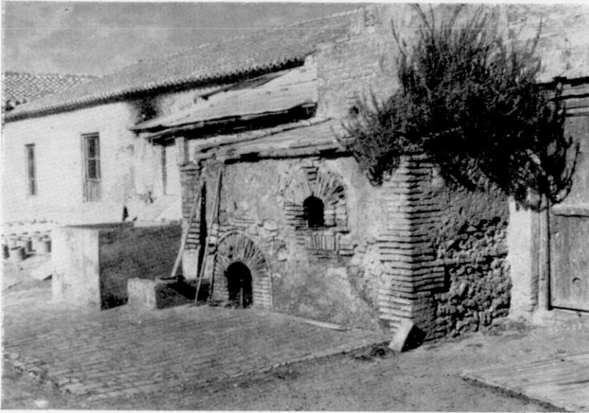
Fig. 1.—ARMELE u horno de reverbero para producir litargirio o acercó, primera materia del barniz.
