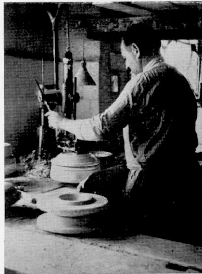
Fig. 4.—TORNO-PRESA PARA PORCELANA. La técnica de este material exige un moldeo especial para evitar la desigualdad en la contracción durante la cochura. (Hispania.)
