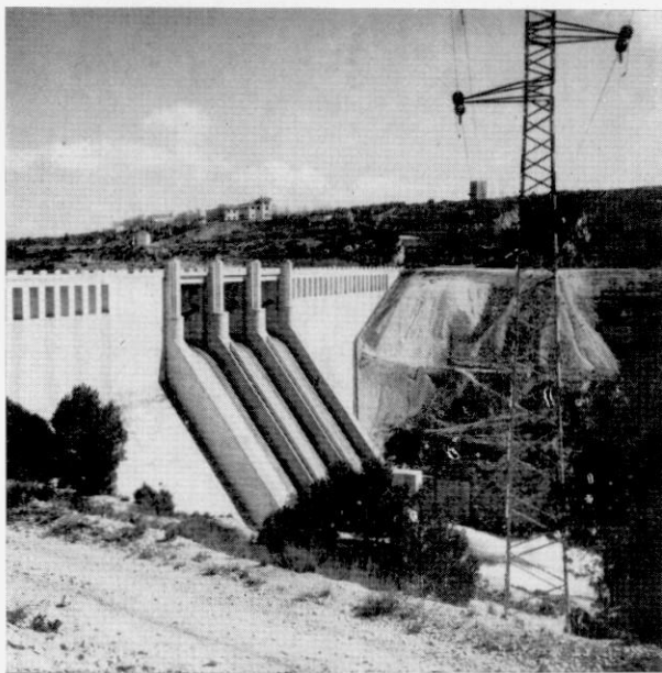
Fig. 2.—Embalse del Júcar (Alarcón). Vista de la presa desde aguas abajo.
