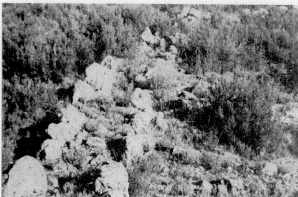
Uno de los anchos muros de Hondonero.
