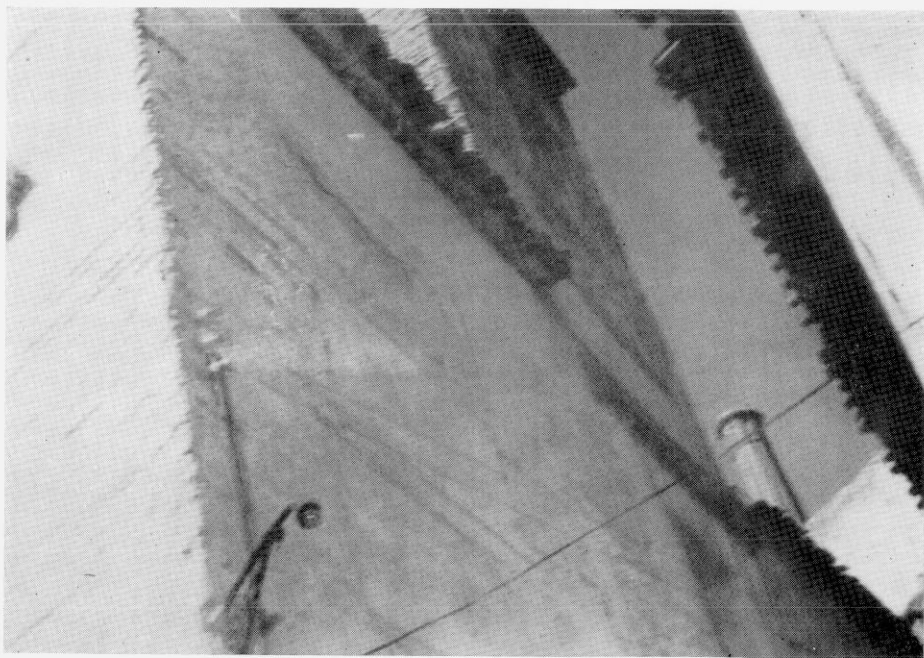
2. Torre de la casa de los Chiclos (s. XVI ?), con alternancia de tapial y ladrillo en la fachada y grandes aleros.
