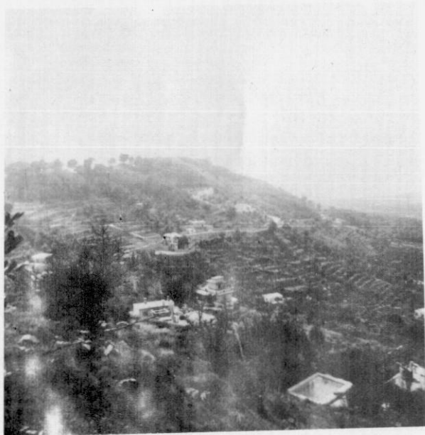
Foto 1.—Masa deslizada en el cerro lindante a l'Aixavegó. Se puede observar la cantidad de residencias secundarias con sus piscinas o balsas de riego que contribuyen a aumentar la peligrosidad del fenómeno con el peso de las edificaciones y el aporte de humedad por infiltración.
