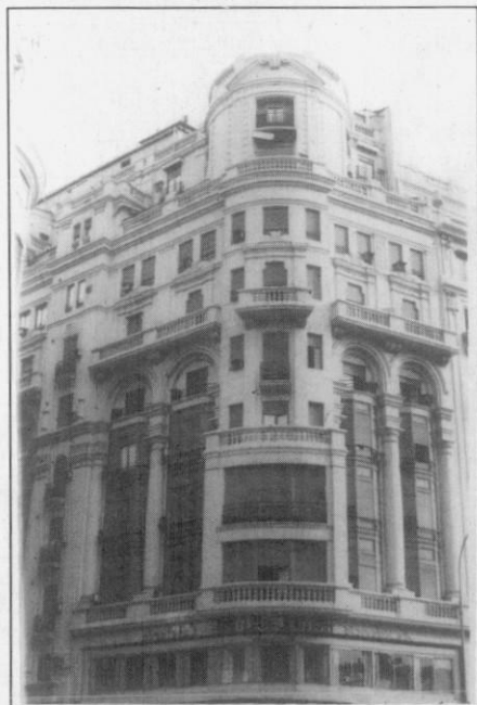
Foto 4.- Edificio Oltra (1929). Francisco Almenar
