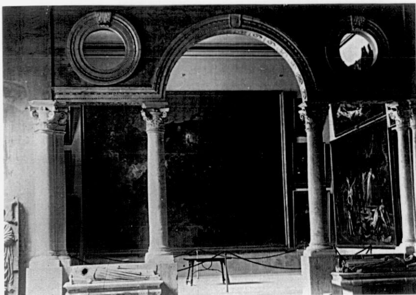
Fig. 3. Serliana procedente del patio del Palacio del Embajador Vich, derribado en 1859. Instalada en la que fue sala Benlliure del antiguo edificio del Museo Provincial de Bellas Artes (El Carmen). Valencia (Foto Archivo Real Academia de San Carlos, 1915. Reproducción Paco Alcántara).
