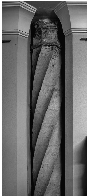
Columna entorchada de la antigua librería de la catedral de Valencia (Fotografía J. Bérchez).
